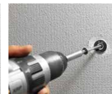
Vorgebohrtes Loch an der Fassade
