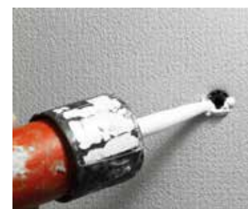
Abdichten des Dübelkopfes im Bohrloch mit StoSeal F 505
