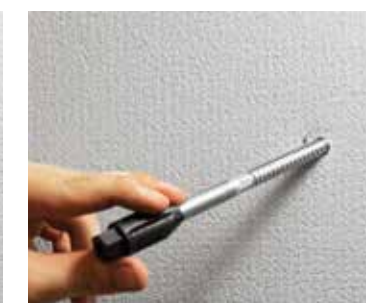
Einsetzen des Dübels Thermax 8/60 in das Bohrloch
