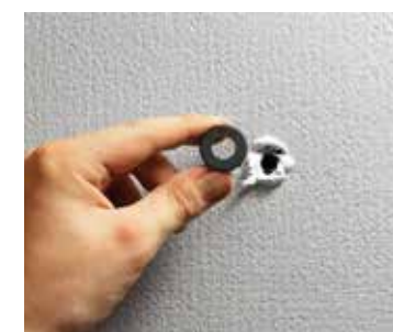
Bohrloch mit ausreichend Dichtstoff
