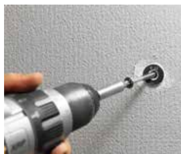
Vorgebohrtes Loch an der Fassade
